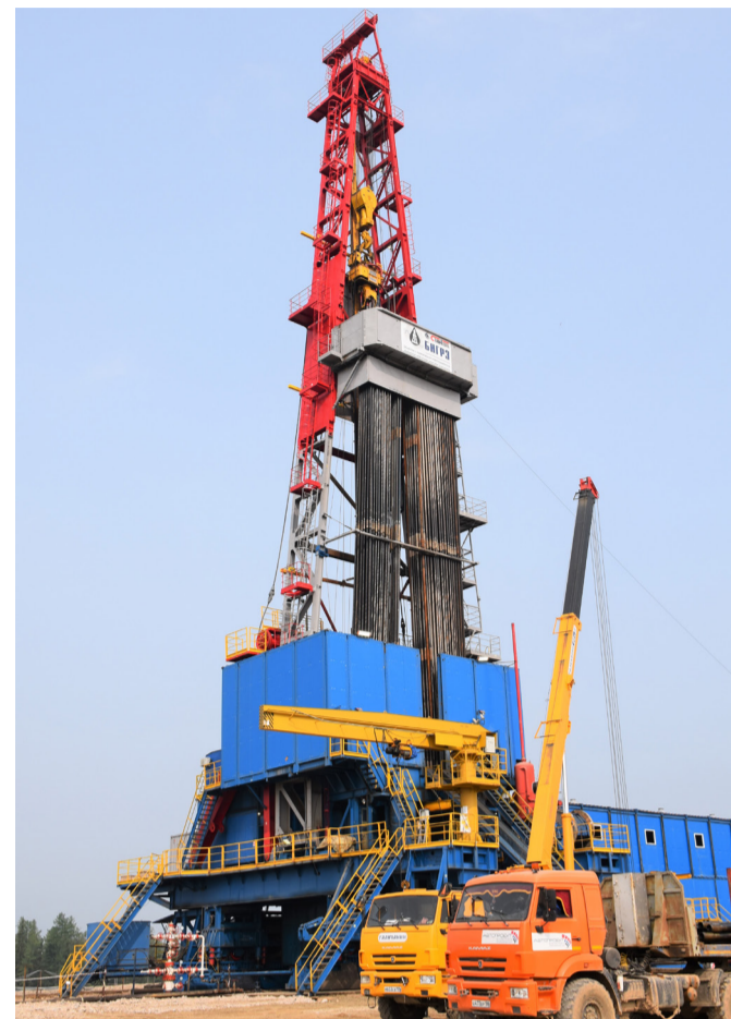
Буровая установка ООО «БНГРЭ» на Курумбинском лицензионном участке
