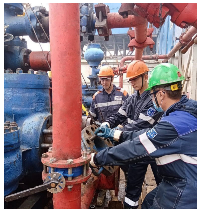
Монтаж бурового насоса на К-274Р. Куюмбинский лицензионный участок
